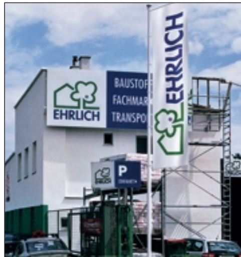
Niederlassung Margaretengürtel der Firma Ehrlich Baustoffe Ges.m.b.H. & Co. KG.
